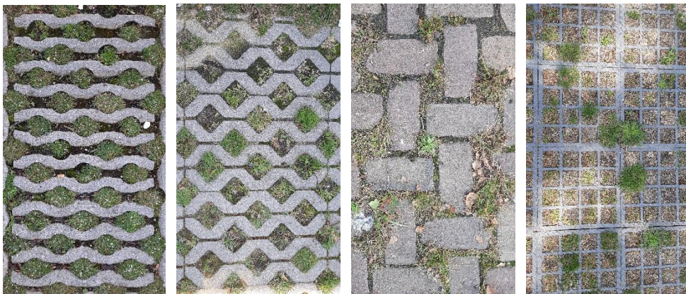
Figuur 5: Onderzochte typen doorgroeibare verharding. Van links naar rechts: 'conventionele' grasbetontegels, nieuwere grasbetontegels, gebakken stenen en TTE roosters.
