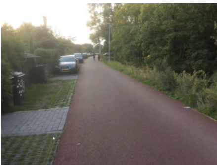
Vechtdijk, aangelegd in eigen beheer, ook bemeten en boringen. Fundering van wit zand, zwarte grond erop aangebracht. Metingen door Hogeschool van Amsterdam.
