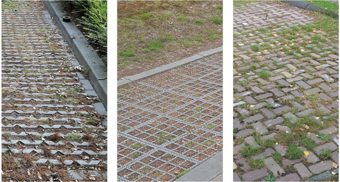
Figuur 15: Voorbeelden van diepteligging van vegetatie van links naar rechts: hol, vlak en bol.
