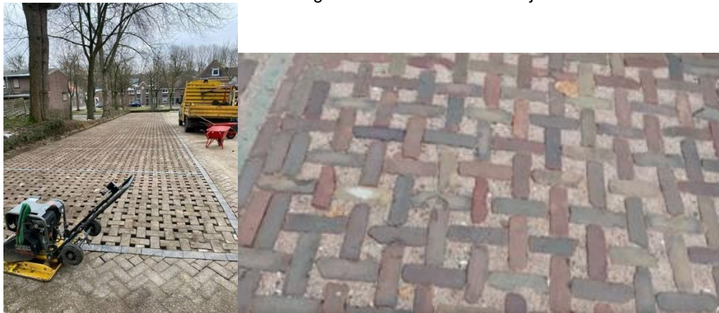
Figuur 25 Oude straatstenen teruggelegd als doorgroeibare verharding in Heerlen (links; https://www.climatescan.nl/projects/10125/detail ) en Leiden (rechts).
